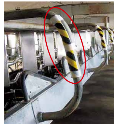
写真4 クッション材を巻いた鉄柱
