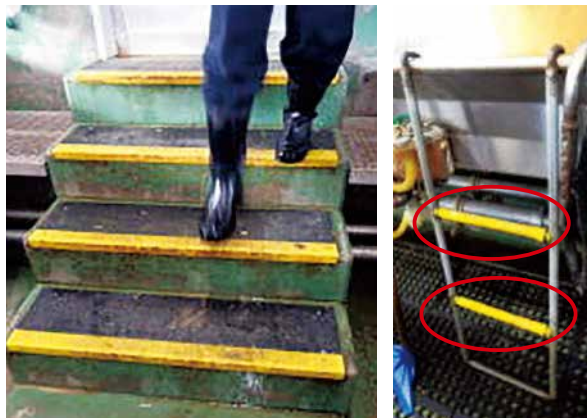
写真2 滑り止めを付けた階段（左）、はしご（右）
