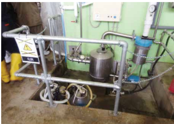
写真1 作業者転落防止の対策
