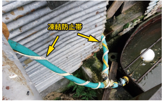
写真4 配管に凍結防止帯を巻き付けた
