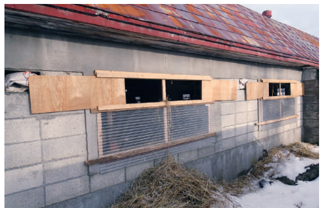
写真3 育成舎に通気窓を設置
