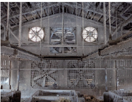
写真1. 台数を制限して換気扇を稼働
