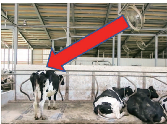
写真5 起立しないと風が当たらない換気扇の角度
