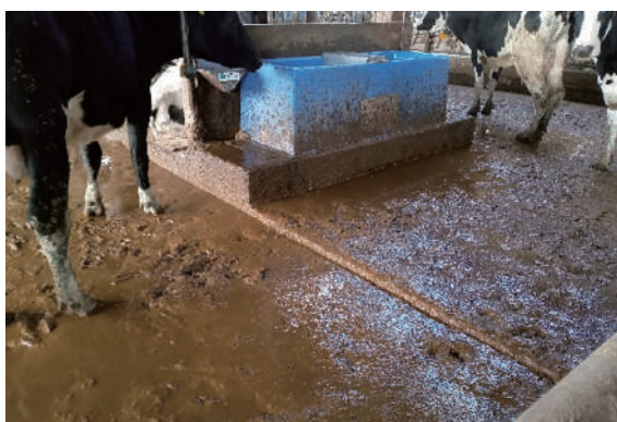
写真7 スラリーによって段差の境目が不明瞭になった通路
